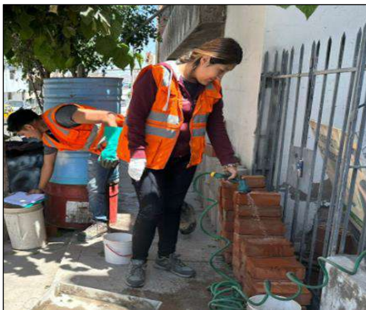
Figura 30. Pilas para el ensayo de compresión axial
