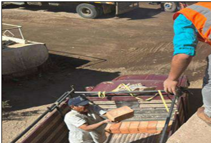
Figura 23. Enfriado y descarga de ladrillos
