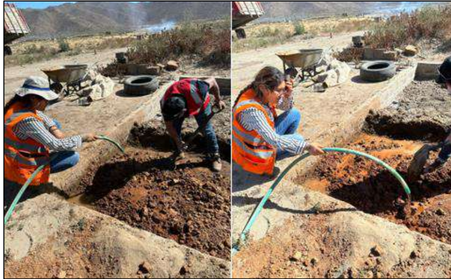
Figura 17. Saturación y mezcla de materiales
