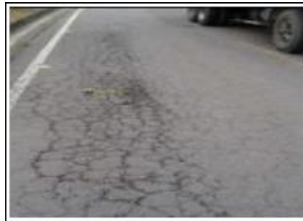
Ilustración 4: Pavimento agrietado
