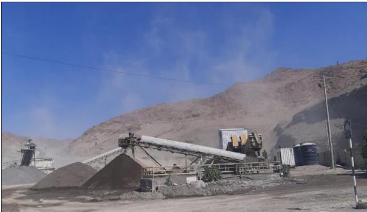
Figura 26. Procesamiento de agregados (chancado primario y secundario), para la obtención de agregado fino y grueso. Fuente: Elaboración propia.
