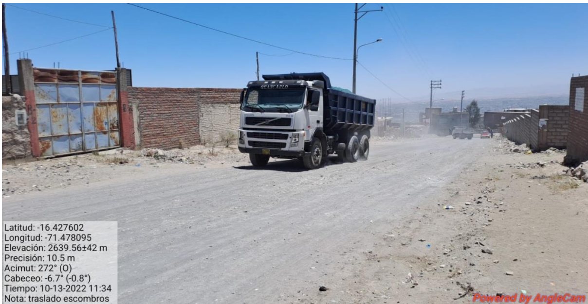
Figura 29. Transporte de RCD a zona de acarreo de material.
