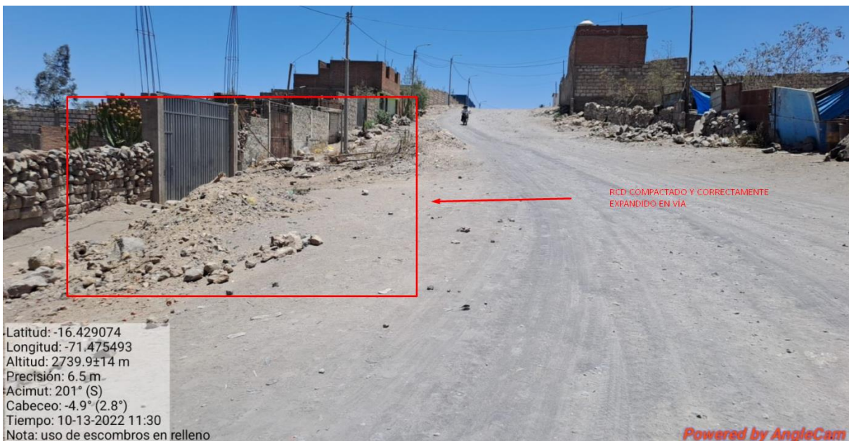
Figura 30. Compactación de material conforme al diseño del proyecto.
