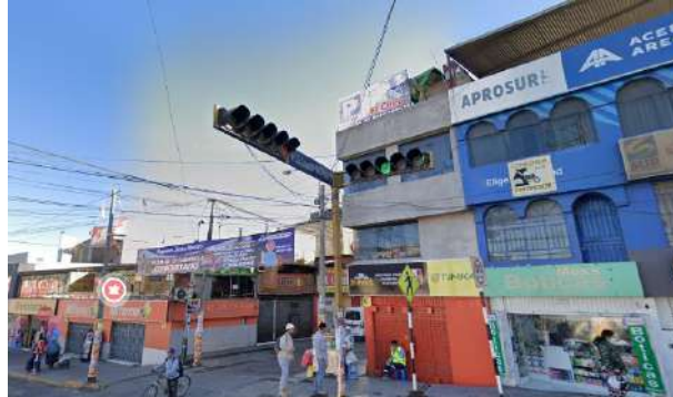
Figura 33. Semáforo ubicado en la Av. Jesús
