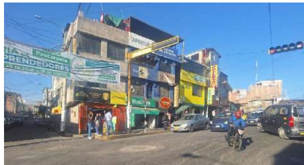
Figura 31. Semáforo ubicado en la Av. Jesús
