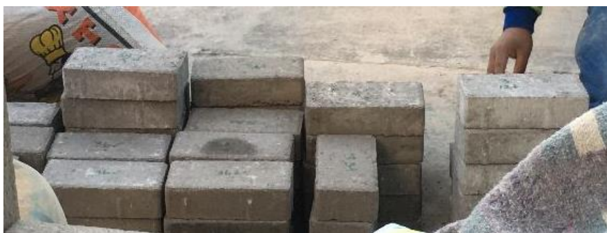
Figura 8: Curado húmedo de los adoquines. Fuente: Elaboración propia.
