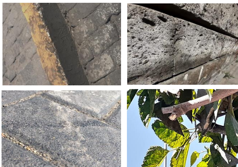
Figura 2. Superficies contaminadas por NO x (Óxidos de Nitrógeno) y Hollín. Fuente: Elaboración propia
